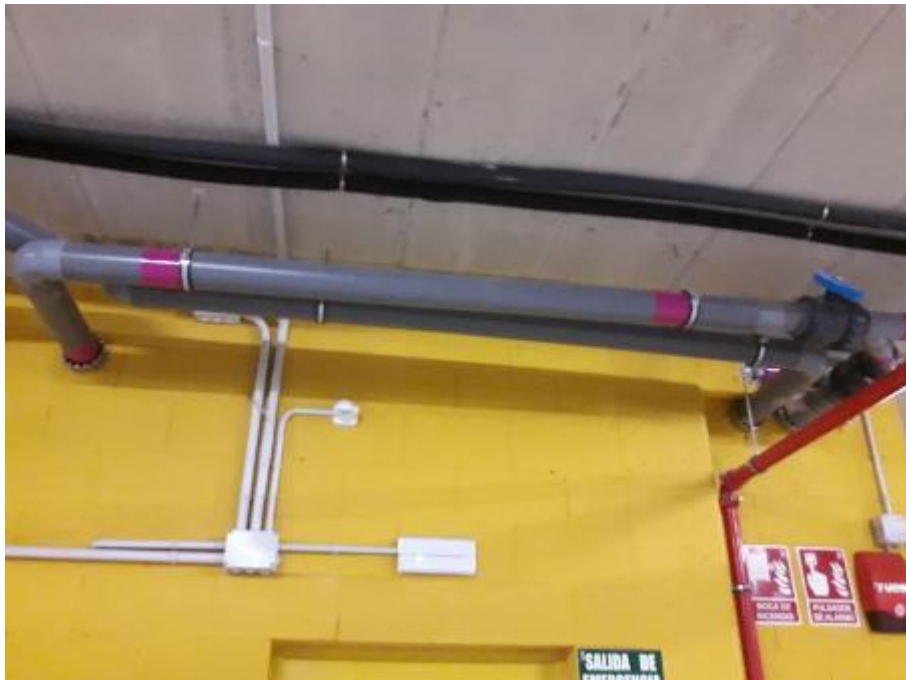
Imatge 1: Franges color porpra a tot el tram vist de canonada d'AG al seu pas pel pàrquing. By-pass general tractament AG connectat a clavegueram.
