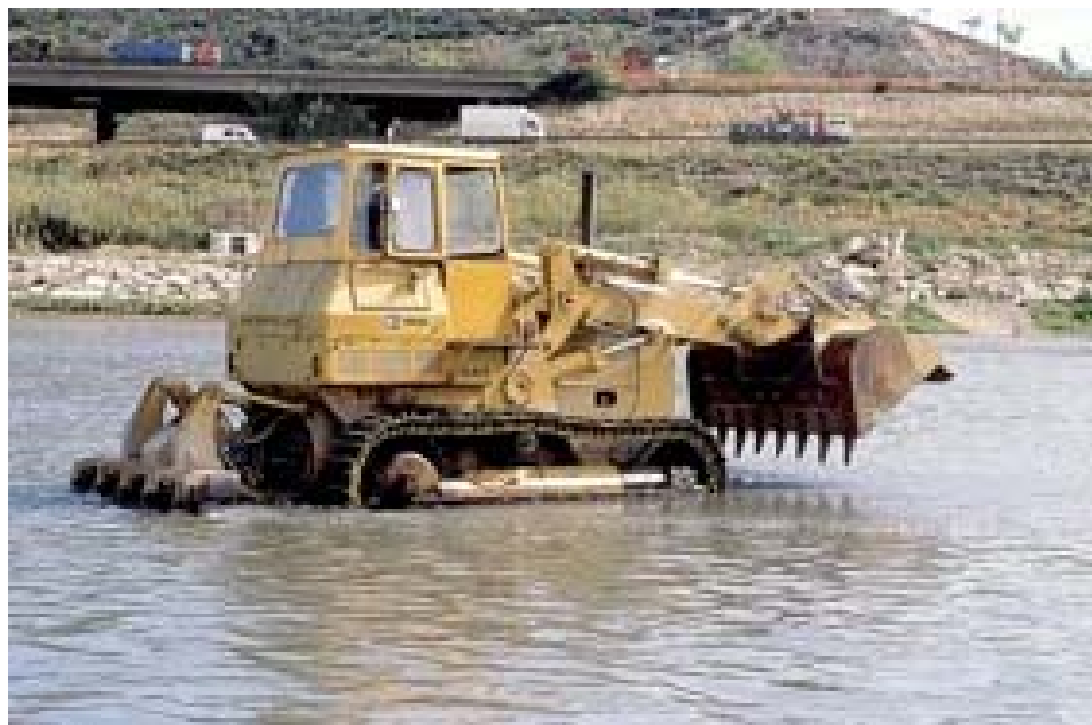
Escarificat al riu Llobregat
